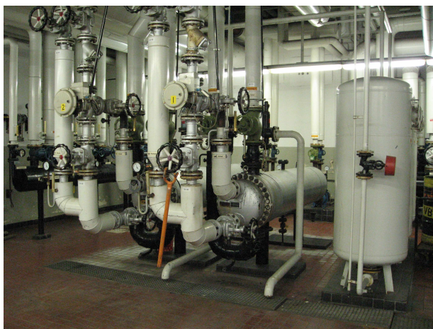
Alte Wärmetauscher für Büroheizung Heizungsverteiler
