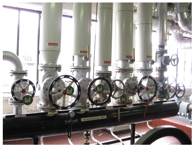
Alte Wärmetauscher für Büroheizung Heizungsverteiler
